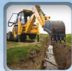
Aménagements de drains
